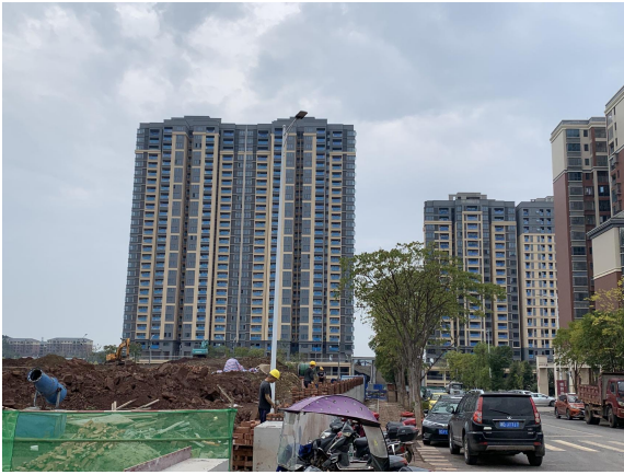
本项目北侧在建小区
