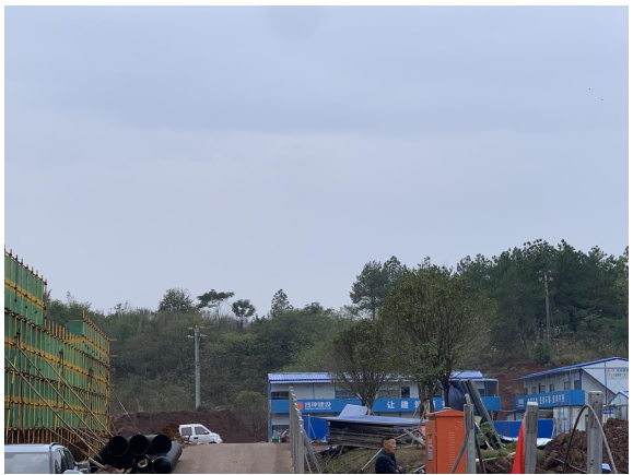
本项目西侧山坡
